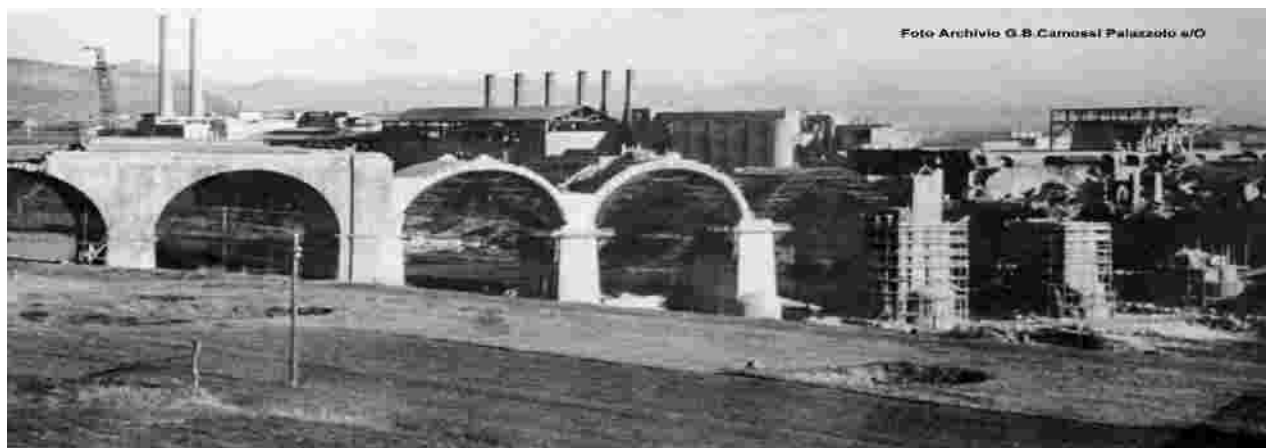
Figura 17. 1946 Italcementi 20 gennaio ponte ferrovia in ricostruzione con Italcementi sei camini.
