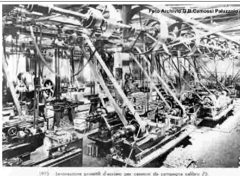
Figura 48. 1915. Lavorazione proiettili per cannoni calibro 75 da campagna. Fonte - Archivio G. B. Camossi.
