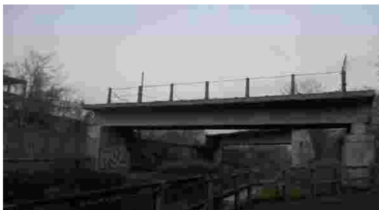
Figura 54. Resti del collegamento tra l'Italcementi e la stazione ferroviaria di Palazzolo.
