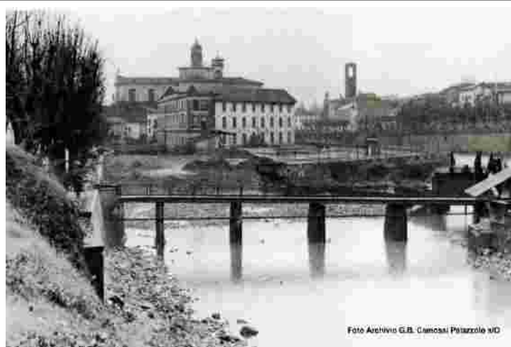
Figura 34. Il ramo del fiume Oglio senza acqua per la demolizione della Niggeler & Küpfer.
