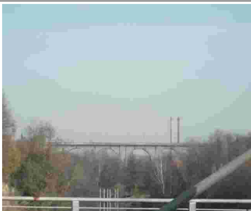
Figura 12. Il ponte ferroviario.
