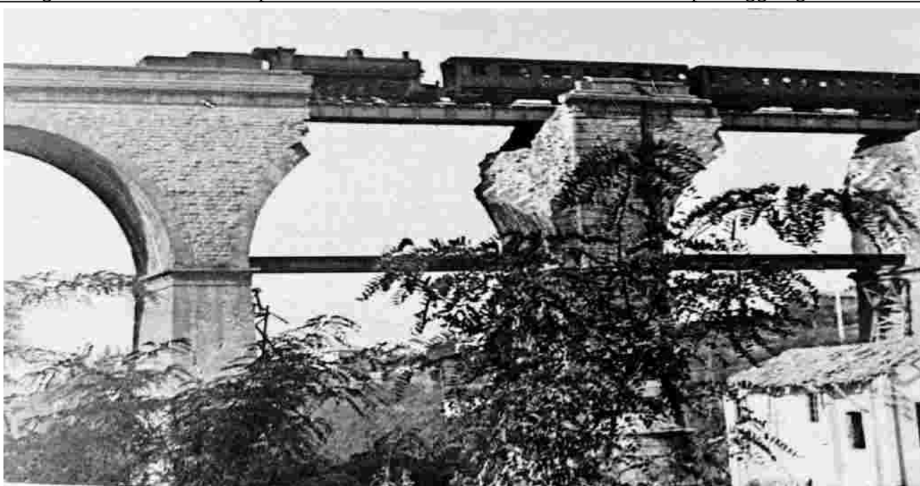
Figura 14. Il ponte ferroviario bombardato.
