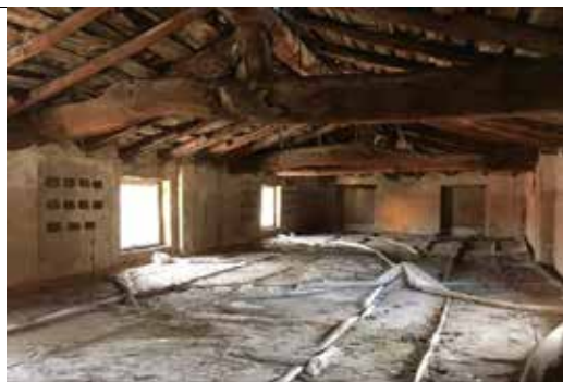
Fotografia del locale sottotetto in cui ci vede la struttura portante a capriate lignee e l'orditura secondaria della copertura ( www.benitutelati.it ).
