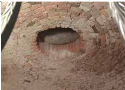
Fotografia della copertura del locale ghiacciaia ( www.benitutelati.it ).
