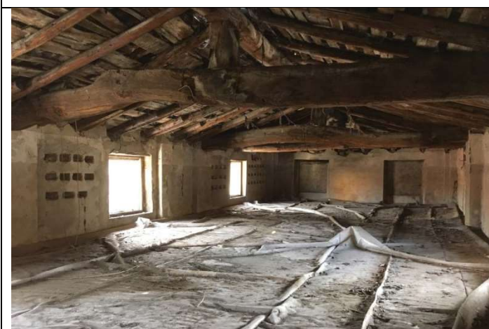
Fotografia del locale sottotetto in cui si vede la struttura portante a capriate lignee e l'orditura secondaria della copertura ( www.benitutelati.it ).
