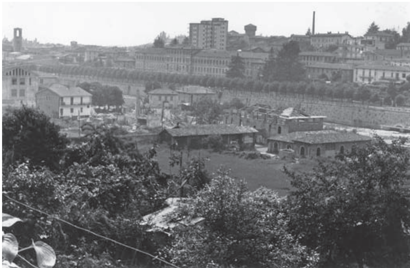
La demolizione dell'isolato ex Nulli
