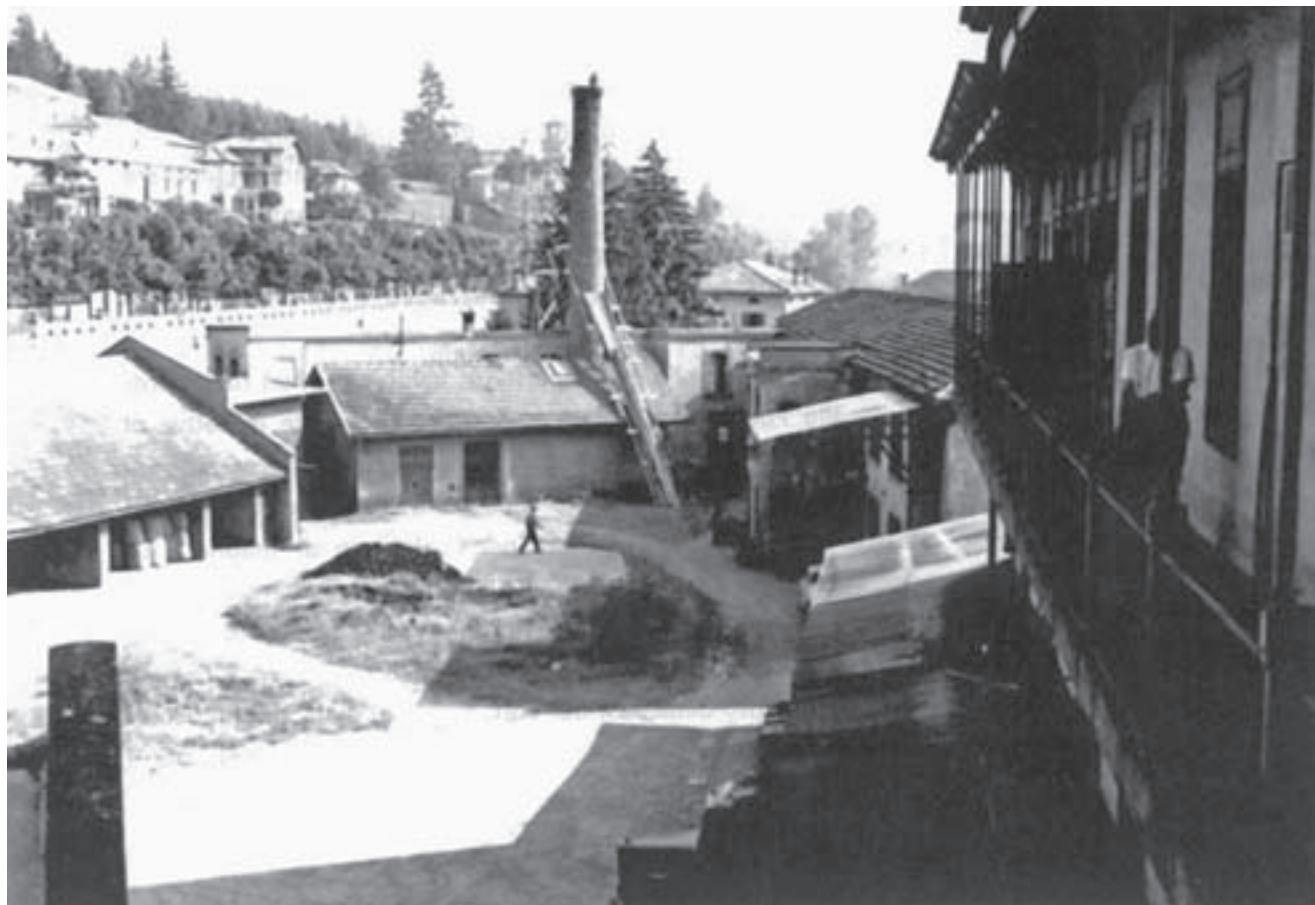
Il piazzale interno del cotonificio NK
