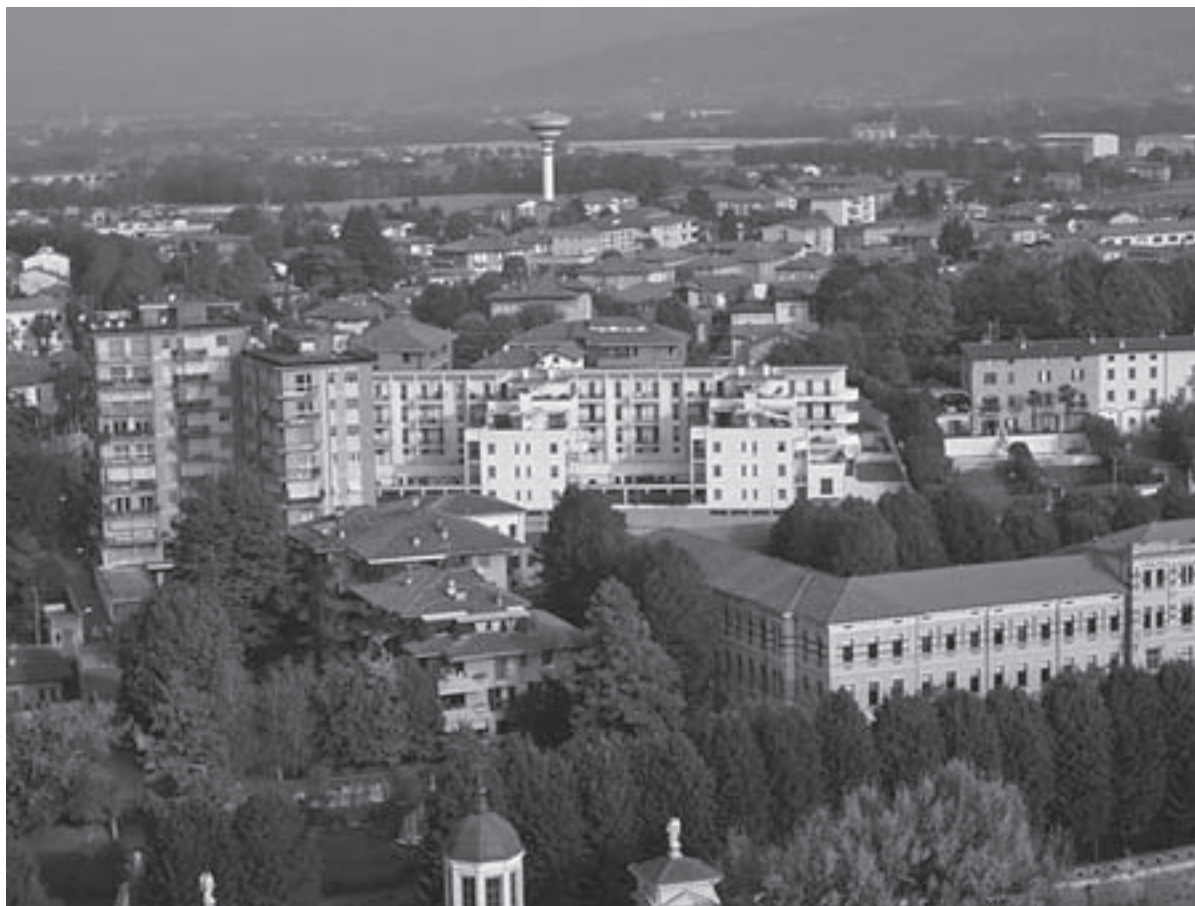
Il condominio del sole e il serbatoio dell'acquedotto
