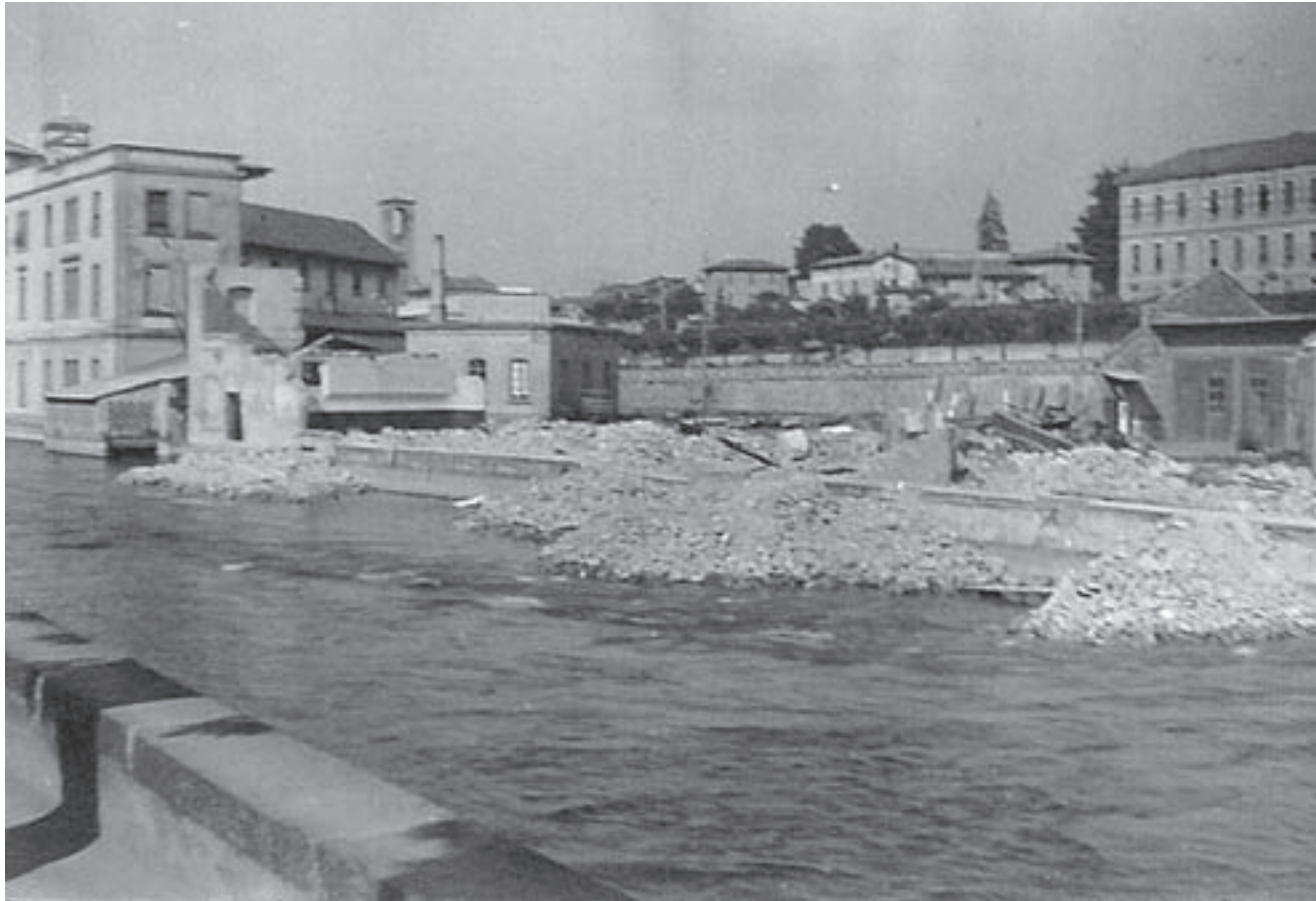
Atterrati i fabbricati
