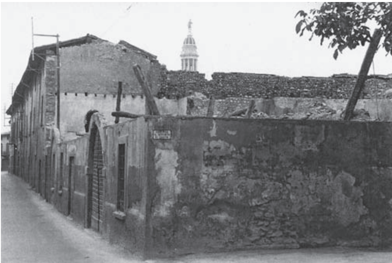
Via Matteotti “el lōc de Anda” in demolizione
