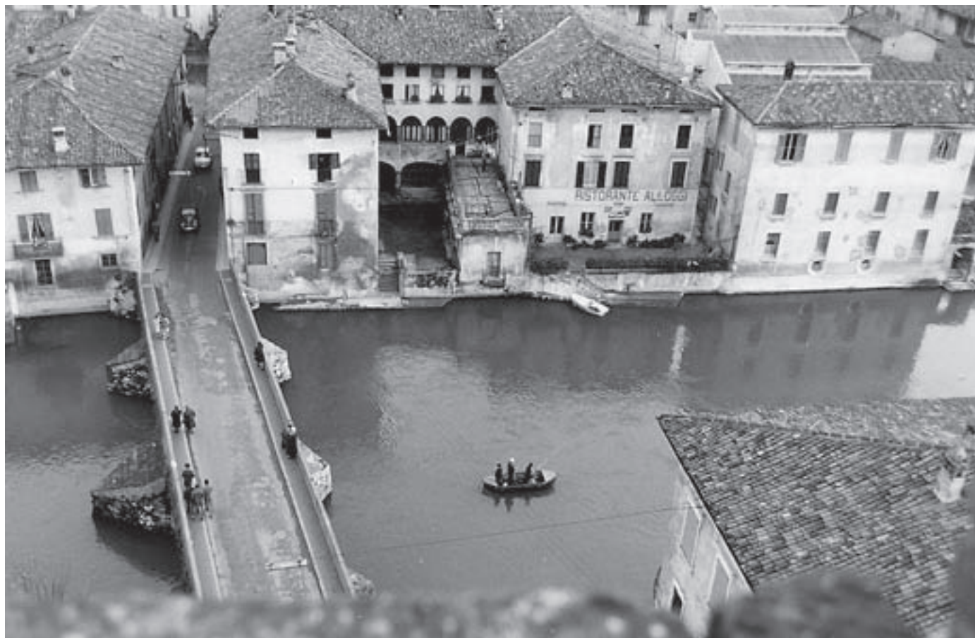
I vecchi edifici a sud del ponte
