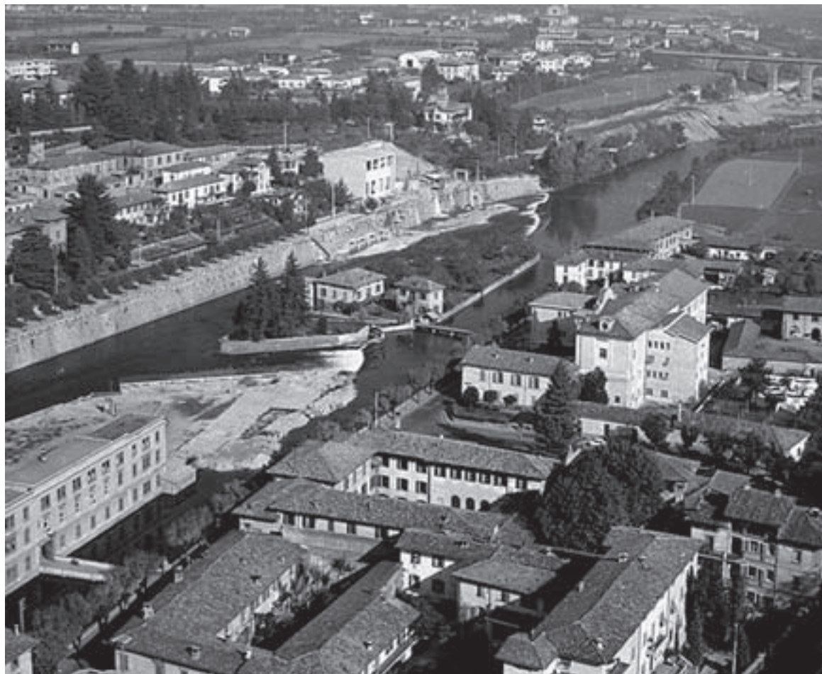
L'ospedale e la nuova centrale elettrica
