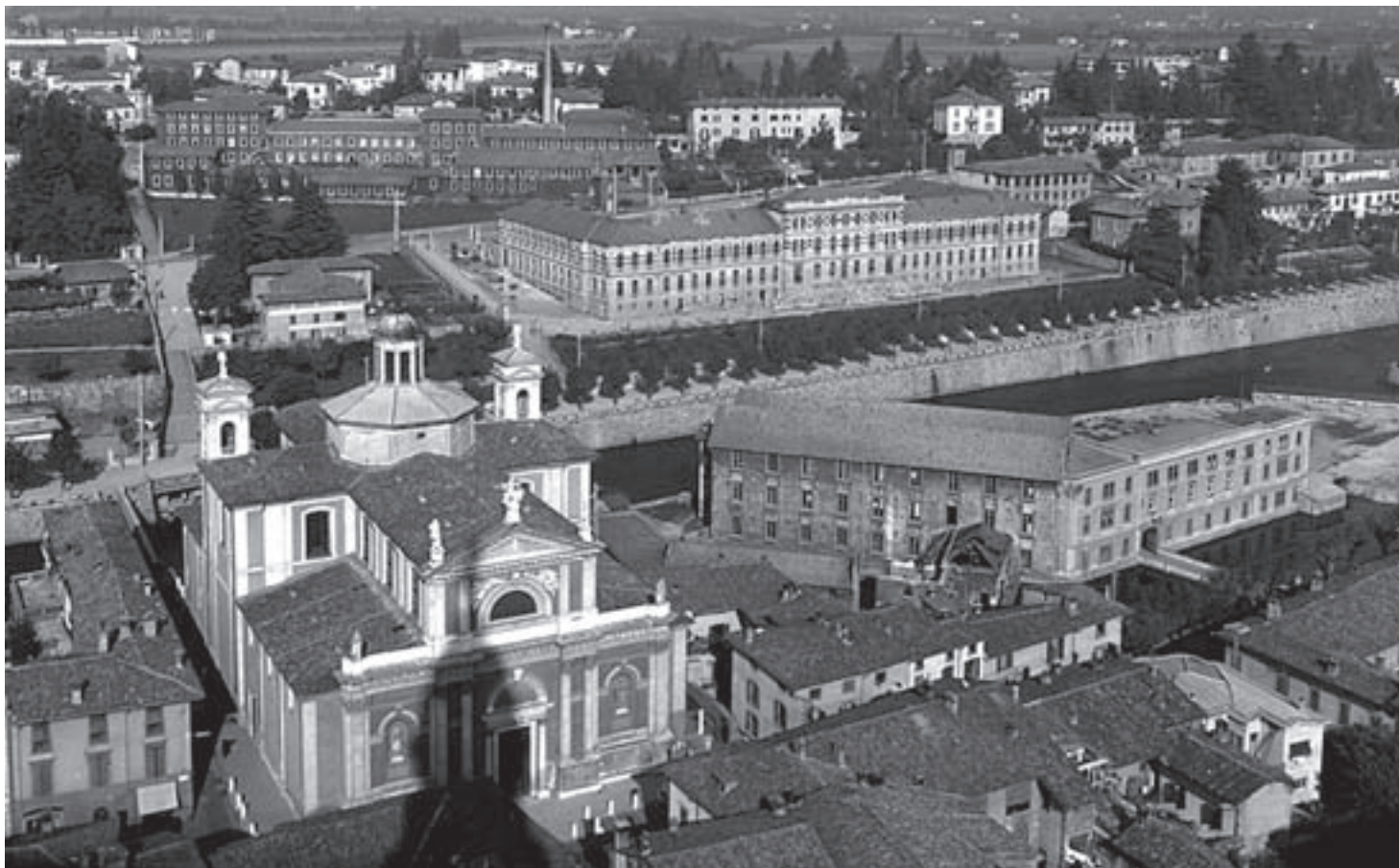
Resti del cotonificio NK e l'edificio scolastico
