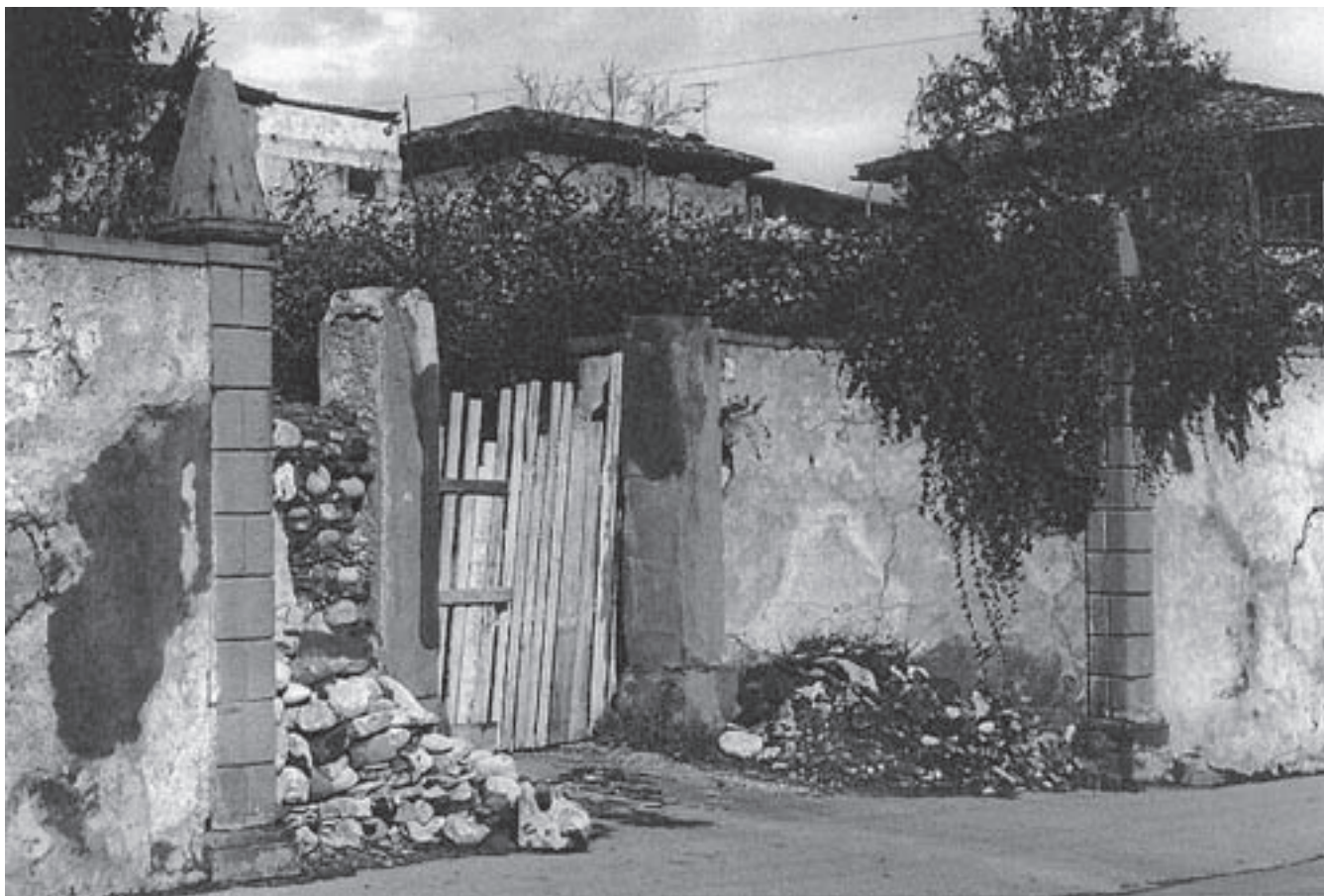
L'ingresso alla Villa Damioli crollato
